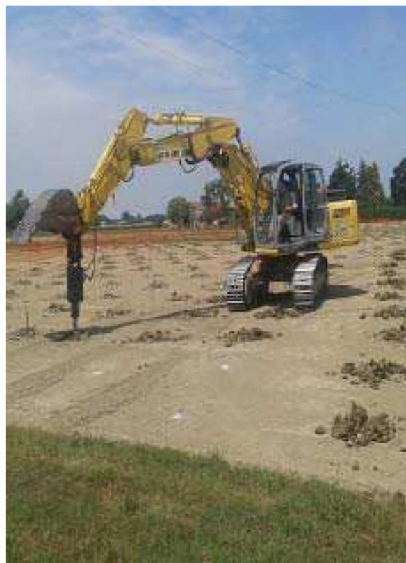
trivellazioni non a percussione, vengono praticati dei fori capaci di contenere la sonda dell'apparato rilevatore.
